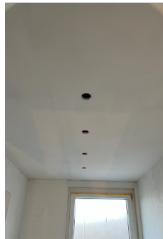
Der Einbau von Deckenspots ist auch im aktiven Teil der Heiz- und Kühldecke möglich.
