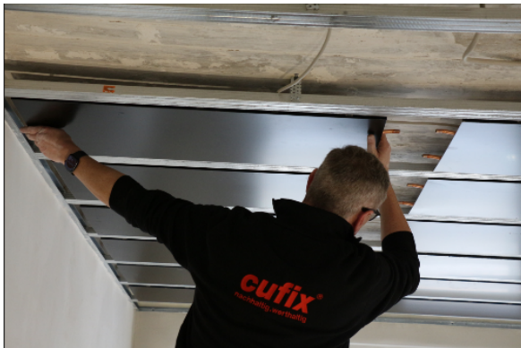
Nach dem Einhängen der cufix ® Register können diese leicht verschoben werden.
