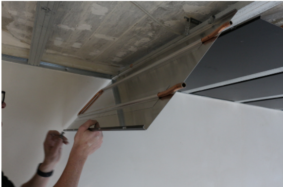
Einfaches Einhängen der cufix ® Register durch cufix ® Z-Haken oder cufix ® Traverse.
