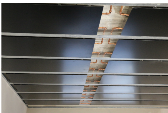
Die cufix ® Register liegen nach der Montage der Gipskartonplatte formschlüssig auf und aktivieren die Deckenplatte.
