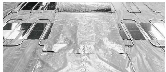
Abdecken mit PE-Folie ca. 0,2 mm. Folie muss nachlaufen können!
