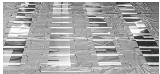
Schutzfolie bei Zement u. Fließestrich
