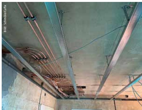
Hydraulisch miteinander verbunden werden die einzelnen Elemente durch ein vorgefertigtes Pressverbindungssystem. Alternativ ist eine Verbindung mittels Steckschläuchen möglich.
