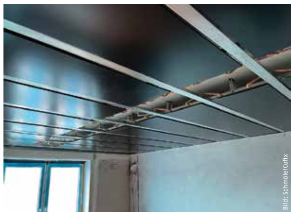
Die Zuleitung zu den Deckenheizkreisen wird mittels Kupferrohr hergestellt.
