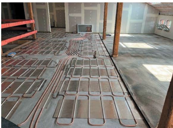
Bei der Einbringung des Gussasphalts ist die Fußbodenheizung drucklos
