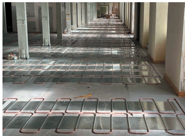
Verlegte cufix® Elemente auf Filzplatte vor der Dichtheitsprüfung
