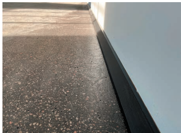
Detailansicht Wandanschluss mit Dreikantleiste
