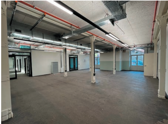
Geschliffener Gussasphalt ohne Dehnungsfuge
