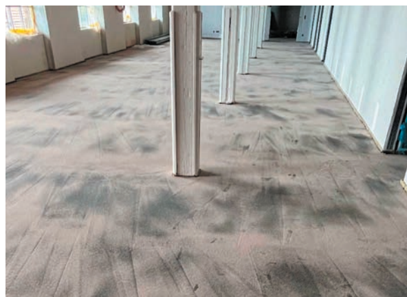
Gussasphaltfläche besandet, vor dem Schleifen
