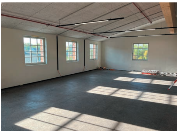
Großer Büroraum im OG ohne historische Stützen
