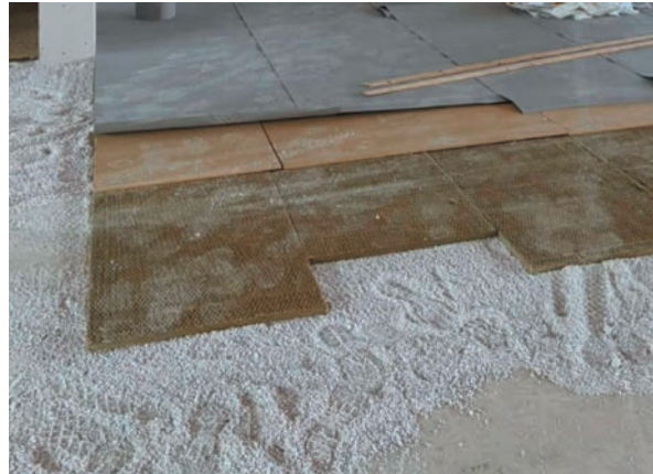
Höhenausgleich und Dämmaufbau
