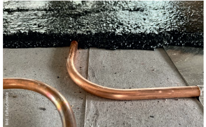
Mit dem Cufix-Fußbodenheizungssystem sind sehr geringe Aufbauhöhen realisierbar. Schon bei einer einlagigen Einbringung des Gussasphalts ab 35 mm spielt das System gerade in der Sanierung seine Vorteile aus.
