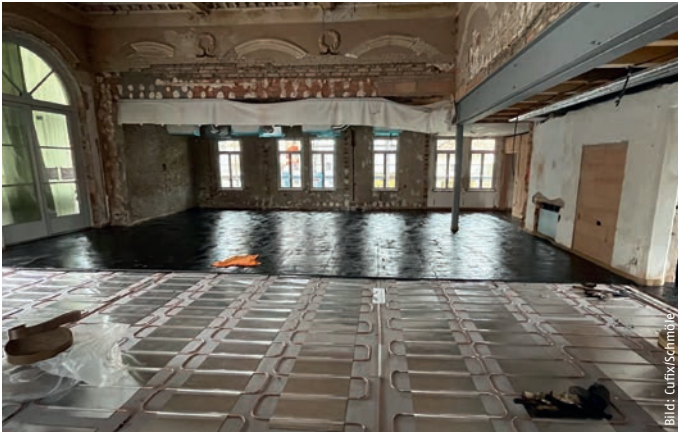
Die 2,00 m langen Hochleistungsregister mit einer Teilung von 12,5 cm werden ausgelegt, miteinander durch Hartlötungen verbunden und im Tichelmann-System angeschlossen. Eine Befestigung der Register ist nicht notwendig.
